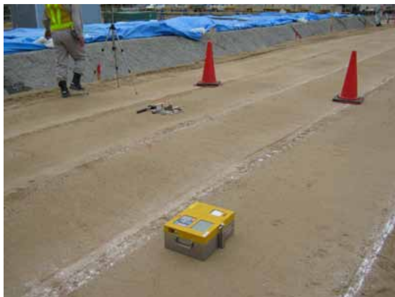
RI による施工管理試験
